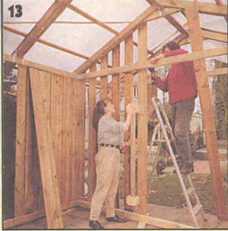
13 Наружные (длинные) доски обшивки обеих фронтонных стен крепят к стропилам. Внутренние доски точно подгоняют по длине и привинчивают изнутри шурупами к наружным.
