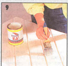
9 Экран отопительной батареи покрывают лаком белого цвета.
