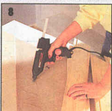
8 Отопительную батарею закрывают экраном из ДСП с наклеенными на нее рейками.
