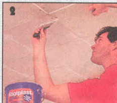
2 Лунки поверх головок шурупов тщательно зашпательывают.
