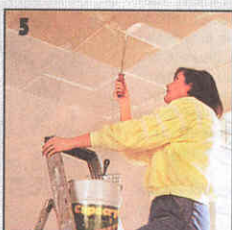
6 ...обои тщательно прикатывают валиком. И потолок, и стены покрывают дисперсионным лаком.
