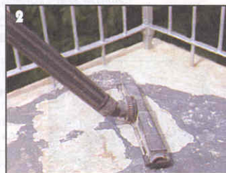
2 Подготовку поверхности завершают, удаляя с нее мелкие осколки бетона и пыль. Лучший инструмент для этого — обычный бытовой пылесос.
