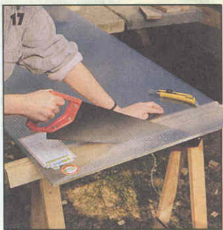
17 Светопроницаемый пластик можно раскрыть поперек обычной ножовкой по дереву, а вдоль — даже острым резком.
