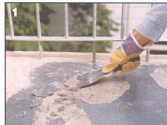
1 Поврежденный участок тщательно защищают от трескавшегося, плохо держащегося верхнего слоя бетона; трещины расширяют.
