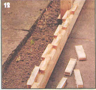
12 Обшивка стен досками, располагаемыми внахлест. Расстояние между наружными досками обшивки должно быть везде одинаковым. Его выдерживают с помощью обрезков тех же досок.
