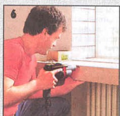
7 К полосе ДСП, увеличивающей ширину подоконника, крепят карниз в ширину плитки.
