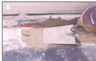
5 Раствор на ремонтируемый участок наносят штукатурной кельмой. Основу предварительно смачивают водой с помощью малярной кисти — это улучшит сцепление раствора с основой.
