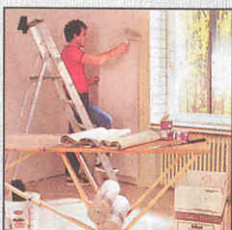
3 Листы рельефных обоев соединяют друг с другом встык. Чтобы не образовались вздутия...
