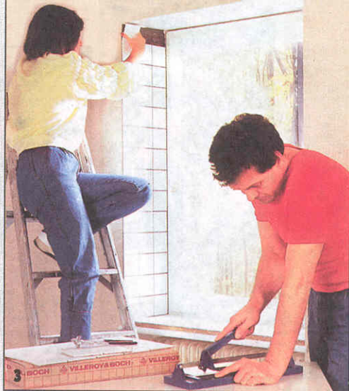
5 Откосы оконного проема облицовывают керамическими плитками, укладываемыми на тонкий слой клея. Плитки для верхнего ряда облицовки выкраивают специальным резак.
