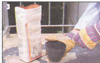
3 Раствор для мелкого ремонта удобно готовить из сухих смесей. В качестве емкости для приготовления раствора подойдет пластмассовый цветочный горшок или детское ведро.
