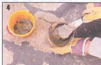
4 Смесь затворяют водой и перемешивают до получения раствора однородной консистенции.
