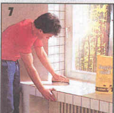
4 Карниз подоконника облицовывают плиткой и расшивают швы между плитками.
