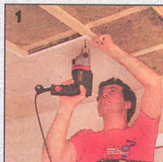
1 Материалом обрешетки для крепления потолочных кассет служат рейки.
