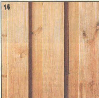
14 Так выглядит стена снаружи. Для обшивки следует использовать только сухие доски, чтобы избежать коробления и растрескивания.
